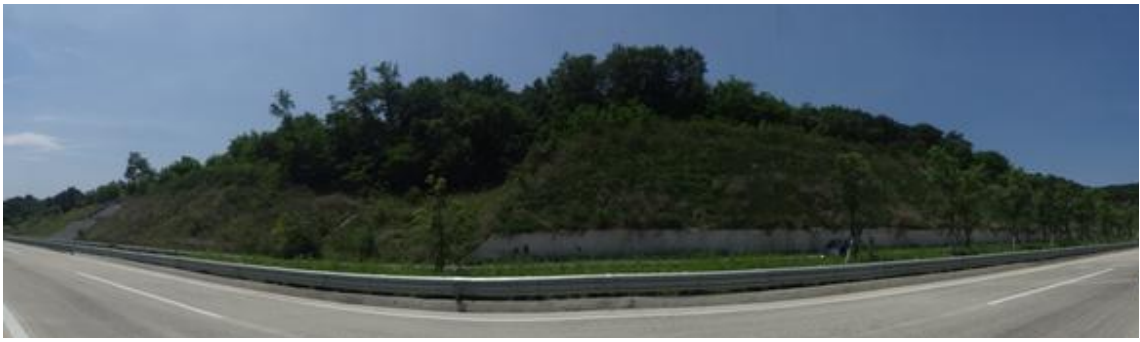
영천절토 19 (관리이정 24.754~24.974km / 3공구 STA.8+740~8+960)
