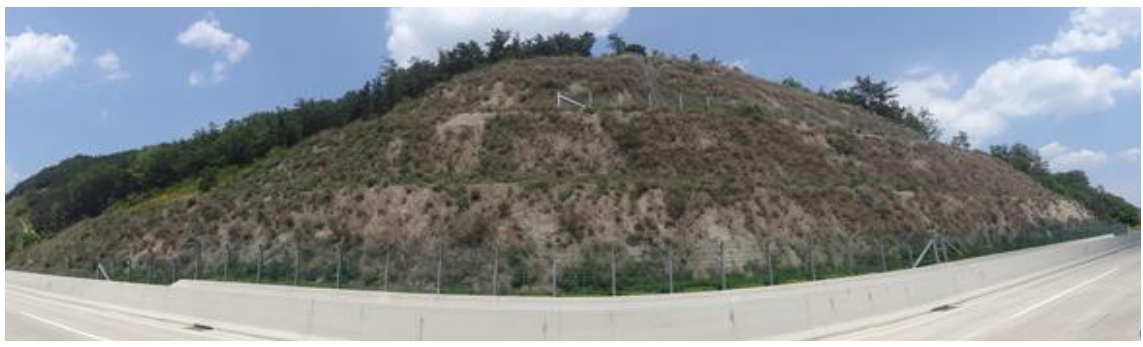
상주절토 15 (관리이정 18.104~18.334km / 3공구 STA.2+090~2+320)
