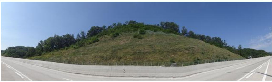
영천절토 55 (관리이정 74.758~74.938km / 8공구 STA.9+400~9+580)
