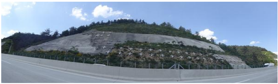
상주절토 43 (관리이정 58.858~59.078km / 7공구 STA.3+300~+3.520)
