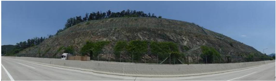
영천절토 6 (관리이정 9.074~9.394km / 2공구 STA.1+680~2+000)
