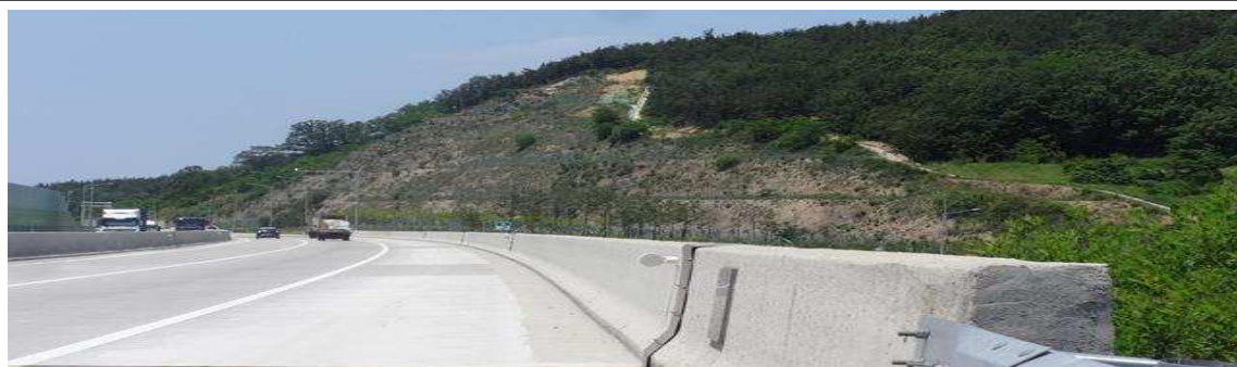
영천절토 4 (관리이정 4.300~5.120km / 1공구 STA.4+300~5+120)
