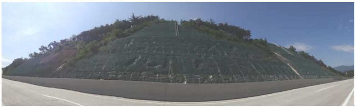
상주절토 47 (관리이정 70.498~70.778km / 8공구 STA.5+140~5+420)
