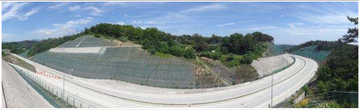
영천절토 59 (관리이정 1.600~1.723km / 8공구 화산JCT RA좌측 STA.1+600~1+723)
