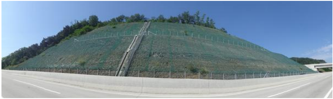
영천절토 58 (관리이정 0.920~1.340km / 8공구 화산JCT RA우측 STA.0+920~1+340)
