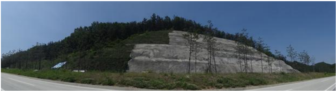
상주절토 27 (관리이정 36.235~36.375km / 5공구 STA.0+000~0+140)
