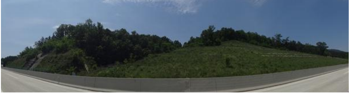
영천절토 22 (관리이정 27.484~27.674km / 3공구 STA.11+470~11+660)
