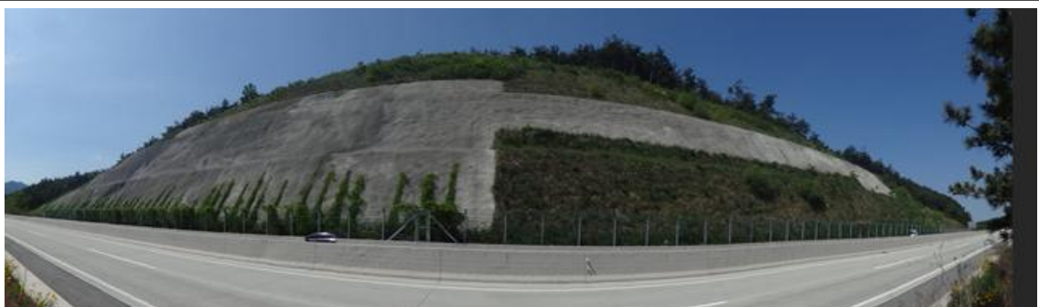
영천절토 40 (관리이정 56.078~56.398km / 7공구 STA.0+520~0+840)
