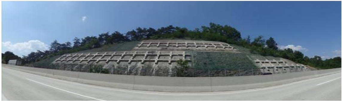
상주절토 50 (관리이정 71.71.478~71.718km / 8공구 STA.6+120~6+360)
