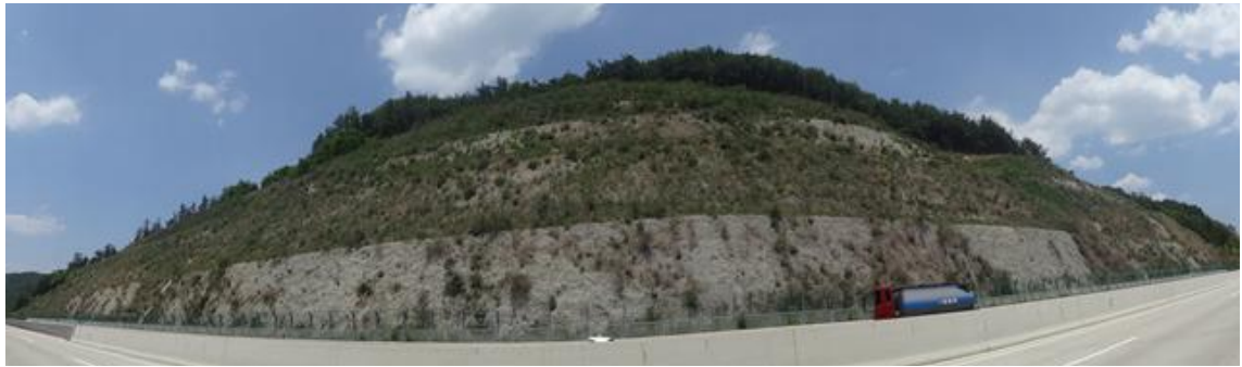
상주절토 14 (관리이정 17.304~17.504km / 3공구 STA.1+290~1+490)
