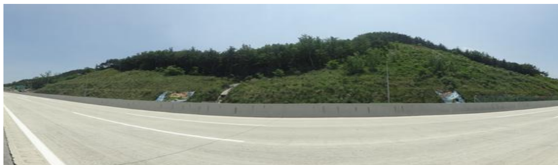
영천절토 1 (관리이정 1.000~1.400km / 1공구 STA.1+000~1+400)
