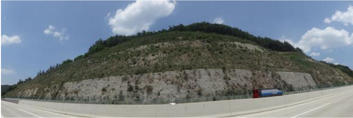
상주절토 13 (관리이정 16.864~17.284km / 3공구 STA.0+850~1+270)
