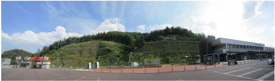
상주절토 42 (관리이정 58.638~58.798km / 7공구 STA.3+080~3+240)
