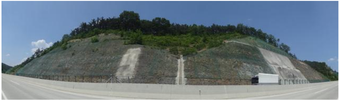
상주절토 30 (관리이정 38.525~38.685km / 5공구 STA.2+290~2+450)
