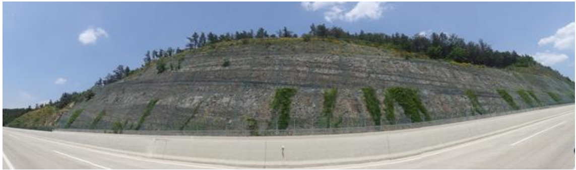
상주절토 10 (관리이정 15.314~15.514km / 2공구 STA.7+920~8+120)
