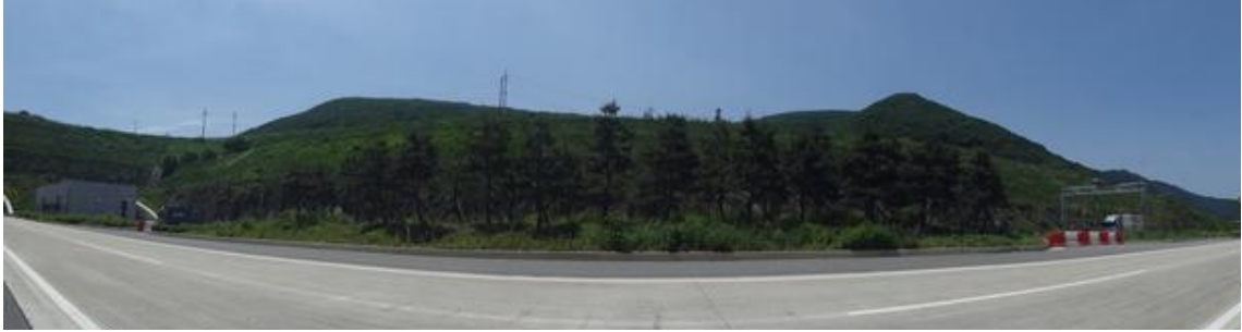
영천절토 18 (관리이정 22.924~23.494km / 3공구 STA.6+910~7+480)
