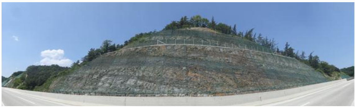
영천절토 31 (관리이정 40.025~40.175km / 5공구 STA.3+790~8+940)
