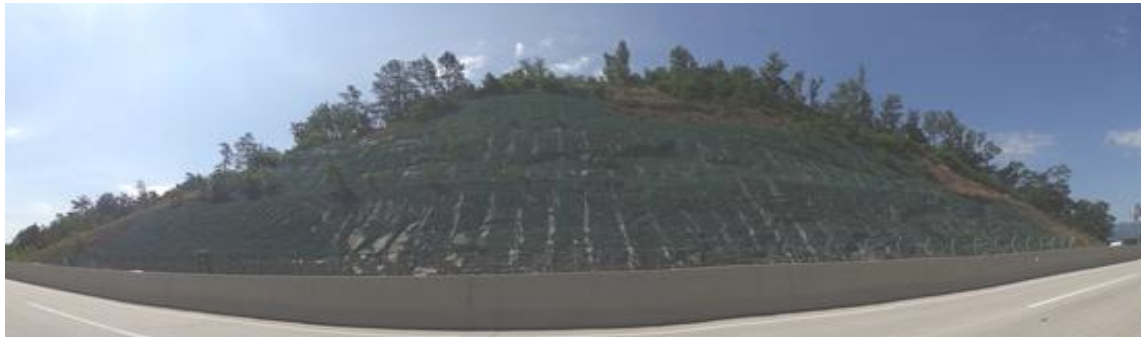
영천절토 46 (관리이정 70.058~70.418km / 8공구 STA.4+700~5+060)
