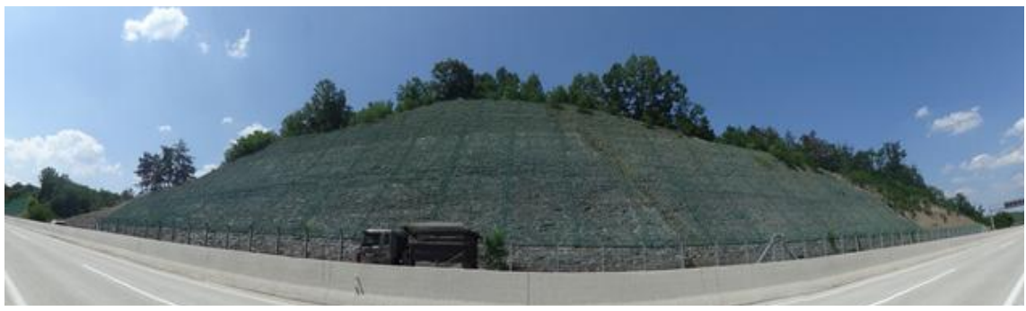
영천절토 51 (관리이정 72.378~72.588km / 8공구 STA.7+020~7+200)
