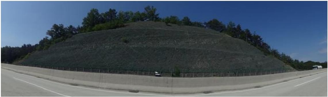
영천절토 54 (관리이정 74.338~74.518km / 8공구 STA.8+980~9+160)
