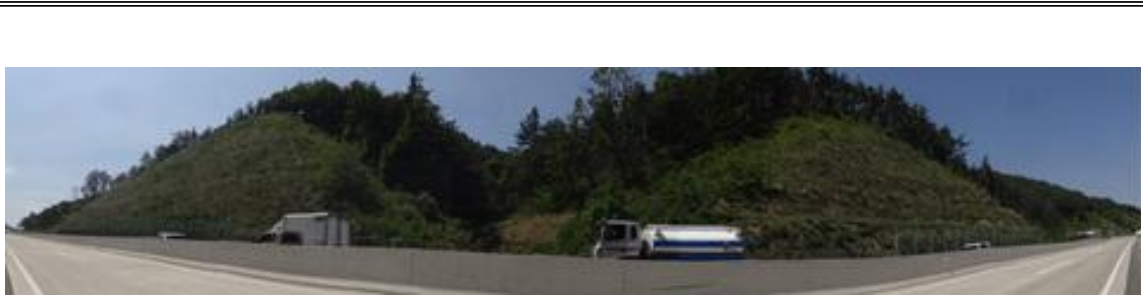
영천절토 39 (관리이정 55.188~55.448km / 6공구 STA.10+970~11+230)
