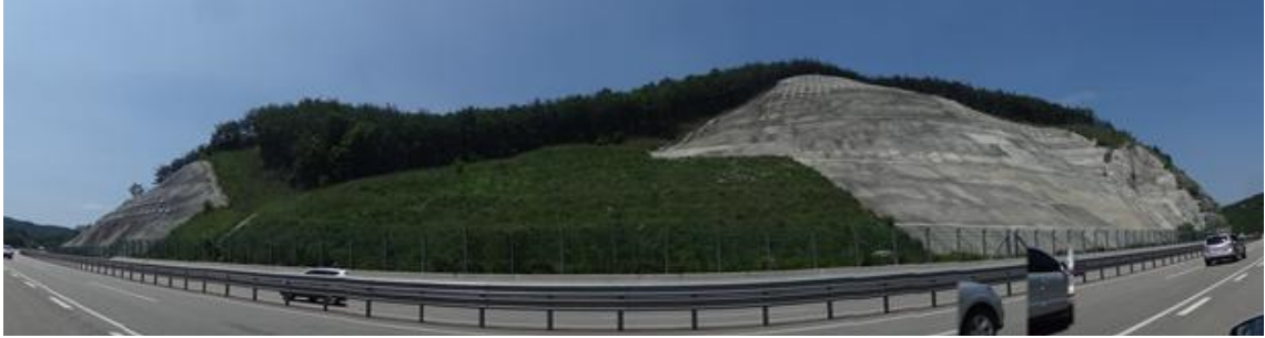
영천절토 26 (관리이정 33.628~33.933km / 4공구 STA.4+645~4+950)
